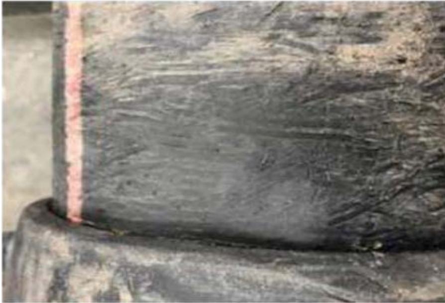
Фиг.8 Грубо остъргана тръбна повърхност с рашпила
